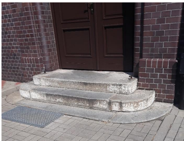
Schody budynek nr 1 – wejście A
