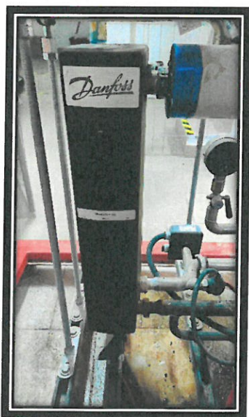
Wymiennik płytowy XB37-1 10L z widocznym wyciekem na śrubunku
